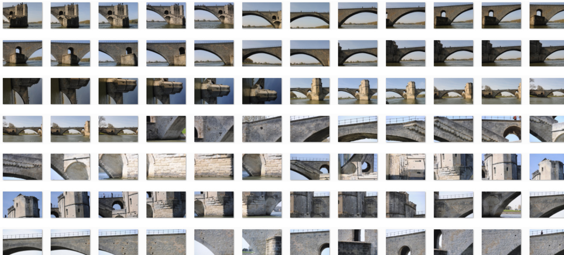
Jeu de photos du Pont d'Avignon acquises depuis un bateau
